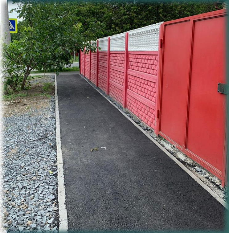
тротуар по ул. Садовая (от ул. Речников до дома № 10/1)
